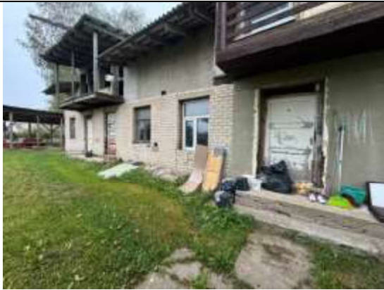
Daudzdzīvokļu ēkas fasāde
