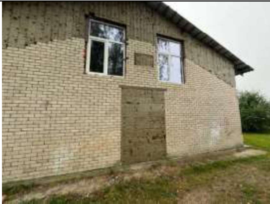
Daudzdzīvokļu ēkas fasāde
