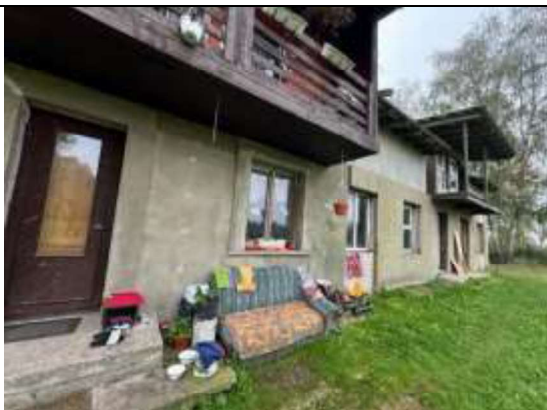
Daudzdzīvokļu ēkas fasāde
