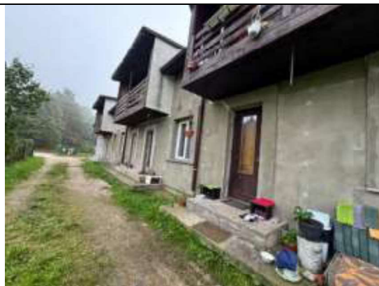
Daudzdzīvokļu ēkas fasāde
